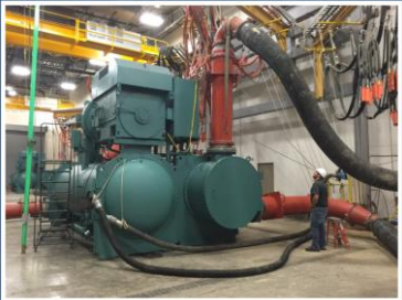
2,500 Ton Centrifugal Chiller – 4,160 Volt
