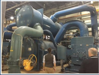
5,000 Ton Centrifugal Chiller - 13,800 Volt
